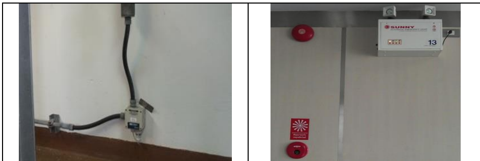
รูปที่ ค-26 Chlorine Detector , Fire Alarm และไฟฉุกเฉิน
