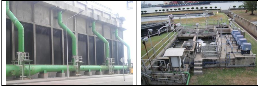
รูปที่ ค-17 ค-18 Cooling Tower และระบบบำบัดน้ำเสีย Activated Sludge
