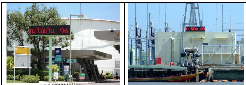
รูปที่ ค-12 จอแสดงผลการตรวจวัดค่าความเข้มข้นของก๊าซออกไซด์ของไนโตรเจนจากปล่องระบายอากาศ ติดตั้งด้านหน้าทางเข้าโรงไฟฟ้าพระนครใต้ และโรงไฟฟ้าพลังความร้อนร่วมพระนครใต้ ชุดที่ 3 ด้านติดแม่น้ำเจ้าพระยา
